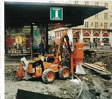
小規模発破、市街地での穿孔
