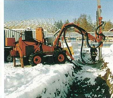
小規模発破、市街地での穿孔
